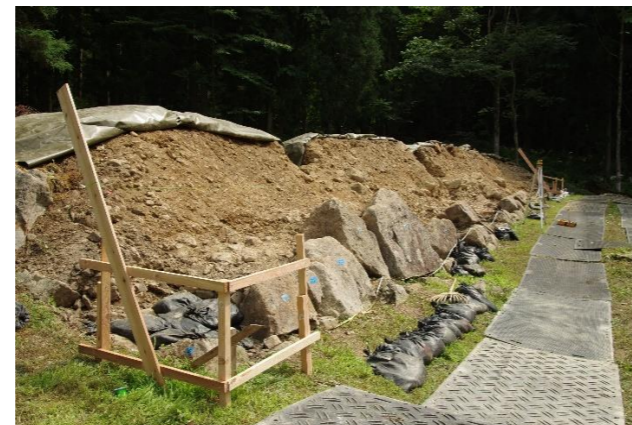
丁張設営(平成 29 年)
