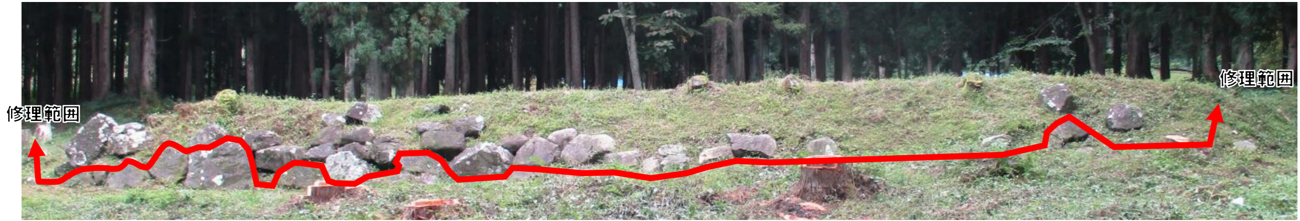
南石垣修復前写真
