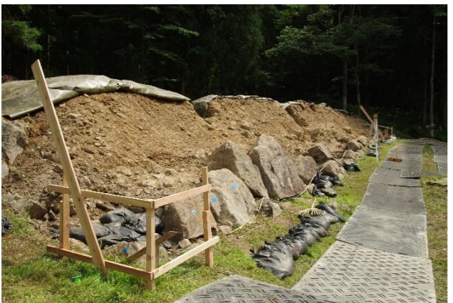
丁張設営(平成 29 年)
