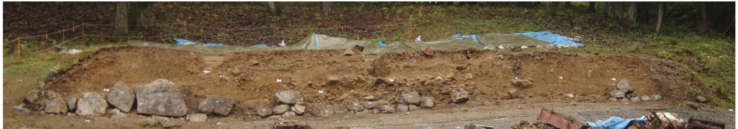
南石垣解体後写真
