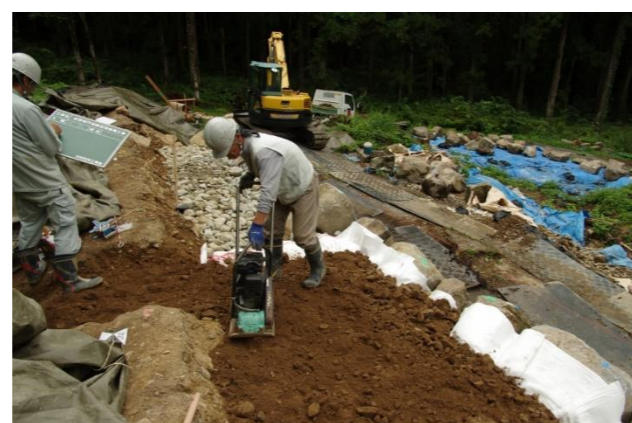
天端仕上げ(平成 29 年)
