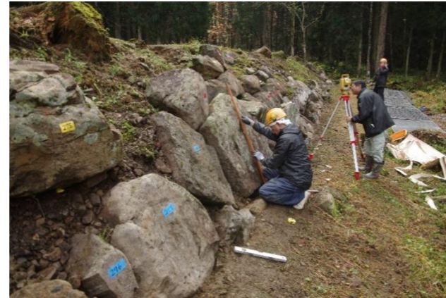
墨打ち(平成 28 年)
