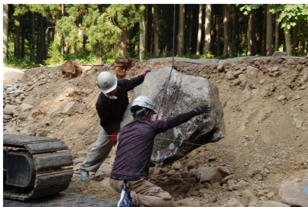
石垣積み直し(平成 30 年)
