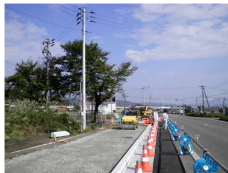
市街地内の歩道整備の様子
