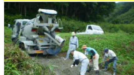
コンクリート舗装
