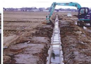
転圧、輪出面の仕上げ
