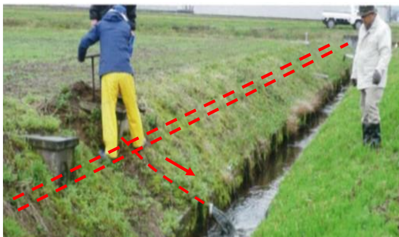
排泥弁の手動確認
