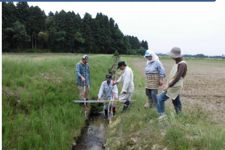
水路の土砂堆積が多くて困った
