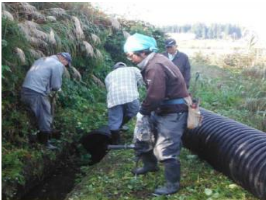
水路のコルゲートパイプ化 による漏水対策
