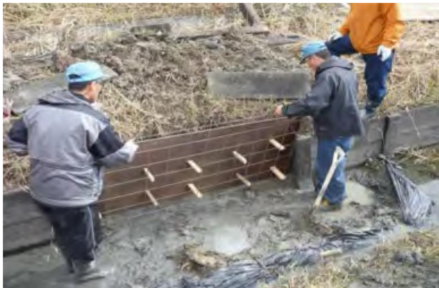
排水路の側壁の補修 (現場打ち水路)
