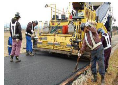
アスファルト舗装
