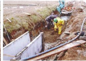
排水フリューム取付け
