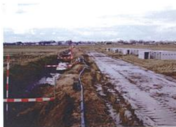
敷き鉄板の敷設
