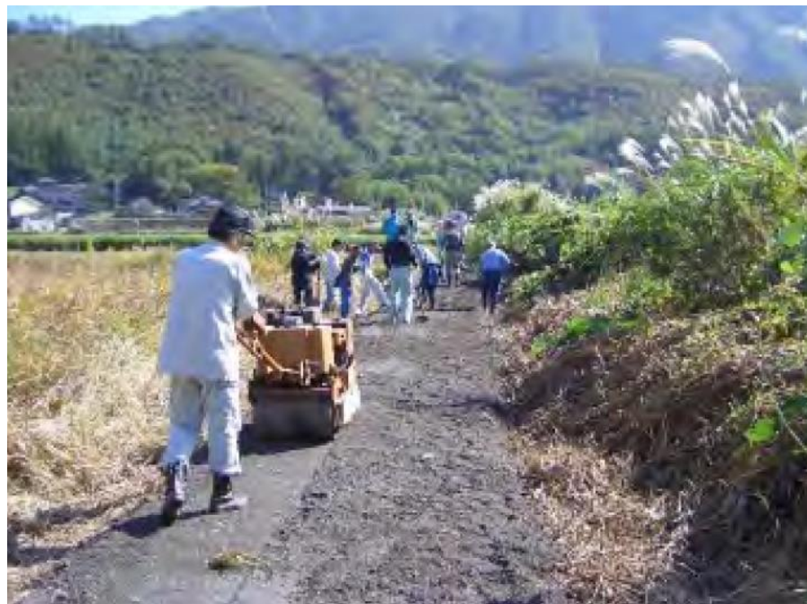
廃アスファルトで農道舗装
