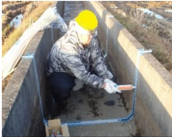
シーリング材塗布
