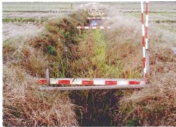
道り方、墨出し
