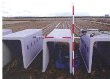
排水フリューム寸法確認
