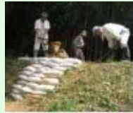
漏水箇所の補修
