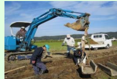
コンクリート水路の更新
