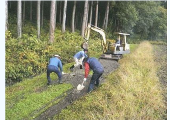
農道修繕作業
