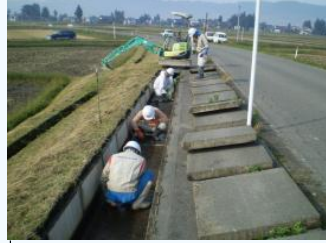
水路補修作業 ②
