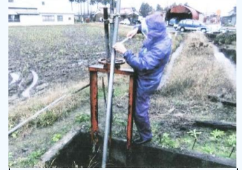
ゲート補強作業
