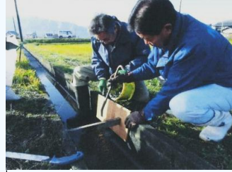
水路補修作業 ①
