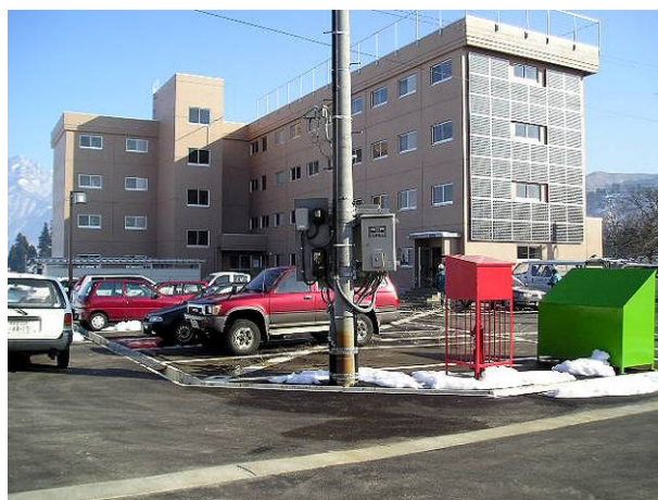
太陽光パネルが設置された公営住宅（舞子団地）
