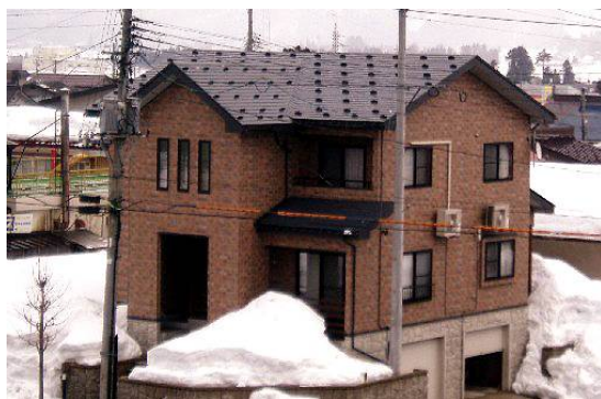
屋根融雪システムが設置された一般住宅
