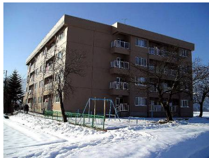
公営住宅の整備（舞子団地）
