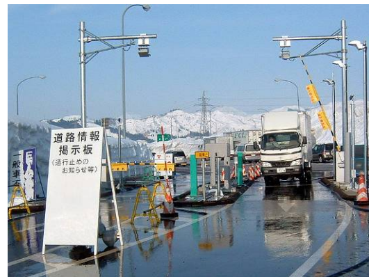
関越自動車道大和 PA における スマートインターチェンジ社会実験の様子
