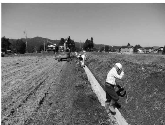
■ 多面的機能支払交付金事業（水路補修）
