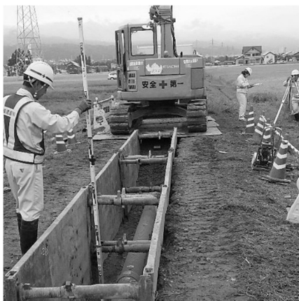
■ 下水道管渠敷設工事
