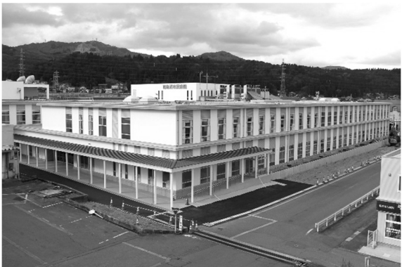
■南魚沼市市民病院（外観）
