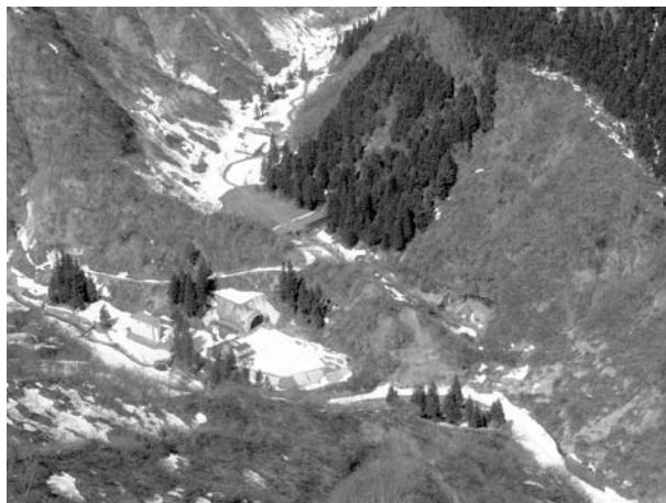
■上越魚沼地域振興快速道路トンネル工事
