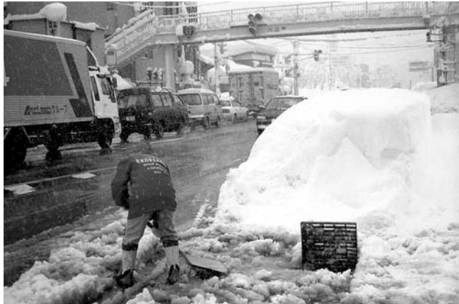
■流雪溝を活用した除雪作業
