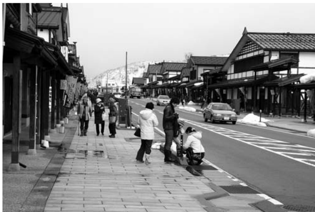
■歩道と街並みが整備された「牧之通り」
