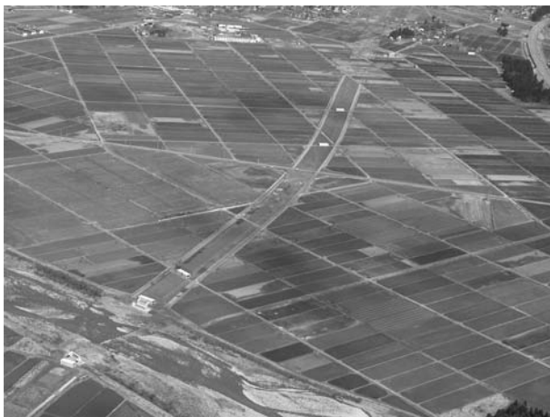
■国道 17 号大和バイパス工事
