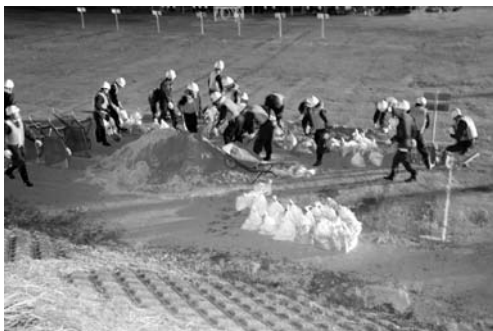
■魚野川夜間水防訓練の様子
