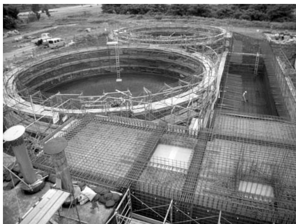
■大和クリーンセンター水処理施設汚水処理槽工事
