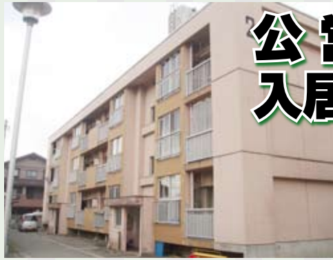
西泉田住宅2号棟
