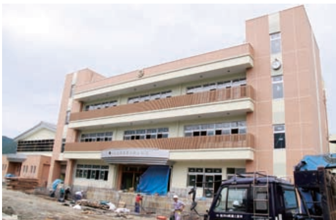
建設中の五十沢小学校(新校舎)
