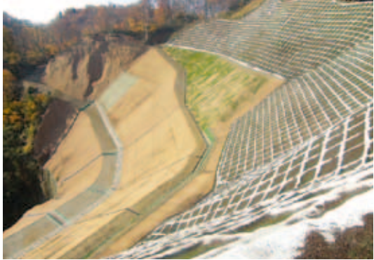
一辺1.5mの法枠吹付工で土留めをしました
