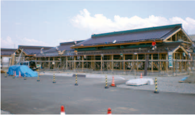
工事中の直売所
