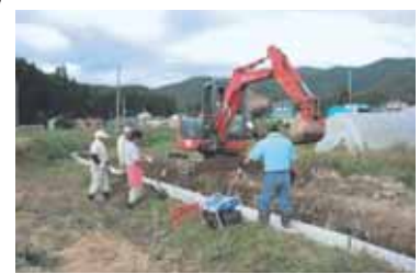
基礎事業：U字溝設置共同作業
