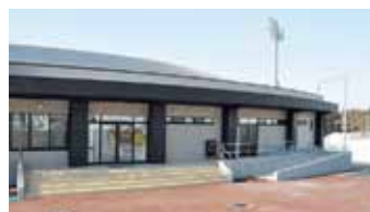
野球場管理棟外観
