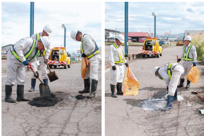
建設課による道路応急修繕
