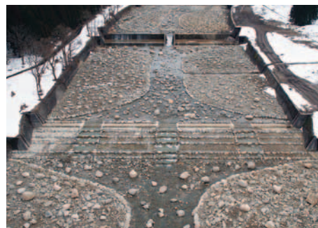
土木工事（魚道工事）
