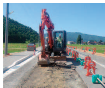
上村さんの重機作業風景
