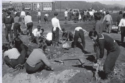
生徒も手伝ったグラウンドの拡張作業〔昭和33年 大巻中学校〕
