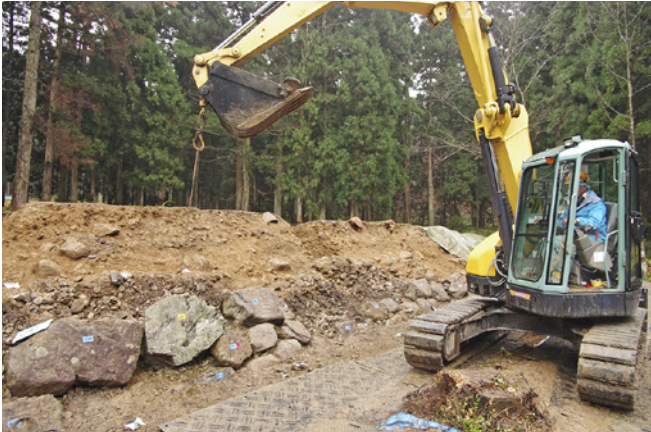
坂戸城跡石垣解体
