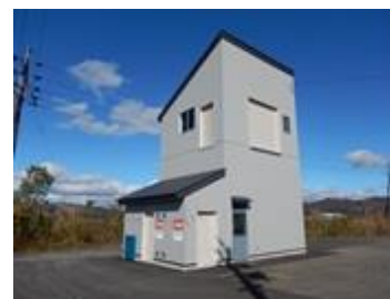
大和分署訓練塔
