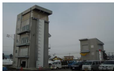
南魚沼市消防署訓練塔
