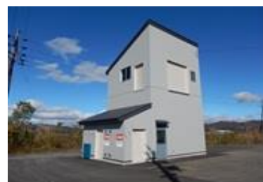
大和分署訓練塔
