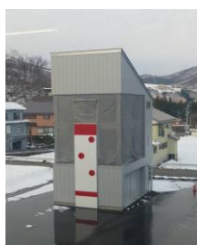
湯沢署訓練塔
