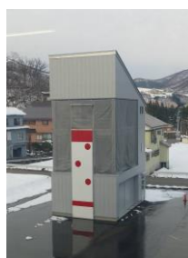
湯沢署訓練塔
