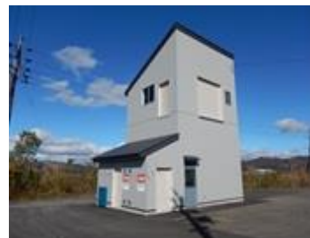
大和分署訓練塔
