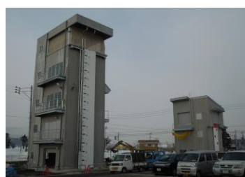
南魚沼市消防署訓練塔
