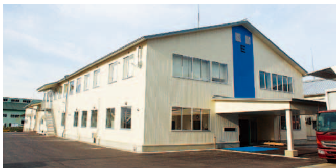
〈最近完成した新工場〉
