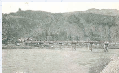
写真1 大正時代の多間橋
