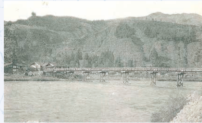
写真1 大正時代の多間橋
