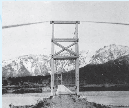
写真1 坂戸橋(つり橋)
