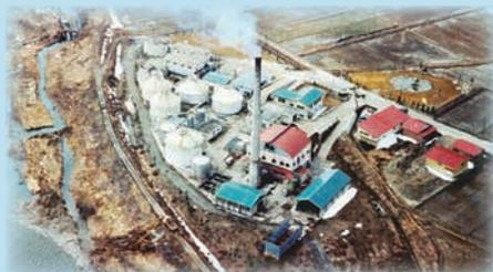
昭和46年に完成した島新田のごみ処理施設の航空写真です。島新田には、昭和58年に2代目の施設が、平成16年に3代目の現施設が建設されました。写真中央部の、白色の丸いタンクはし尿処理施設です。
