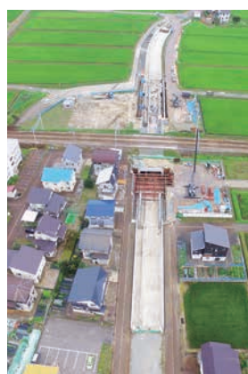
樋渡東西線工事
