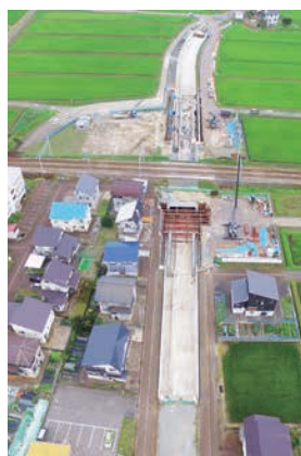
樋渡東西線工事
