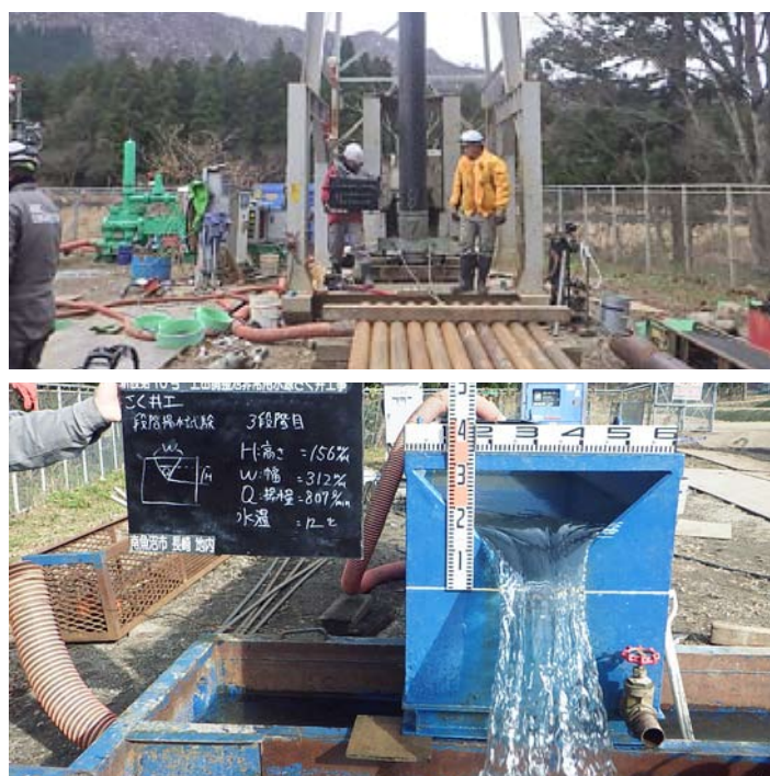
非常用水源の井戸さく井工事
