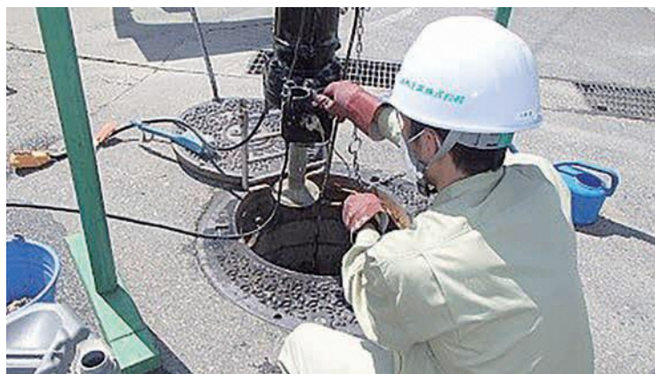
ポンプに詰まったタオルを取除く作業
