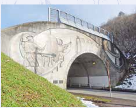
写真2 美佐島トンネル 坂戸側入口レリーフ
