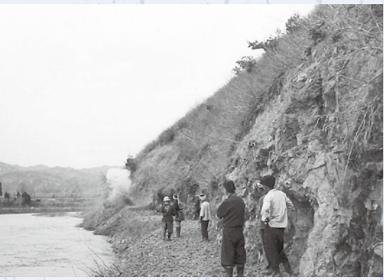
写真1 道路開削の様子
