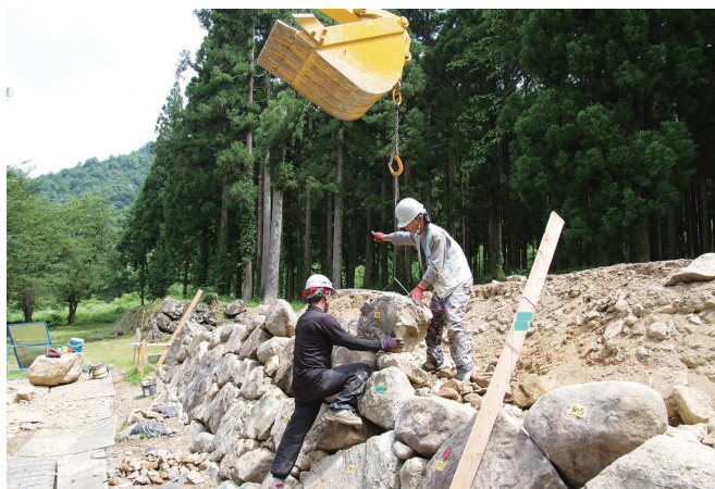
石垣積み直しの様子
