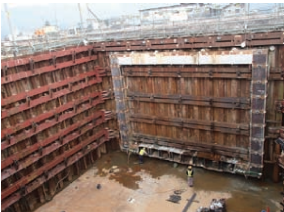
樋渡東西線 (JR上越線アンダーパス工事)
