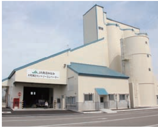
平成28年度事業により整備された施設
