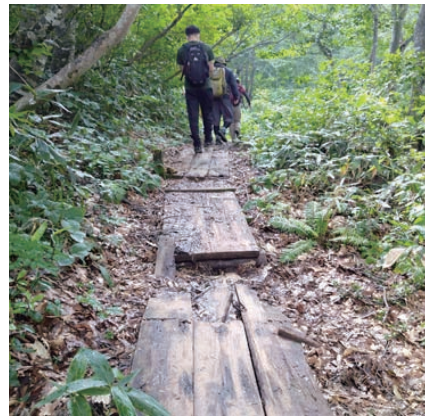
損傷した八海山登山道の木道
