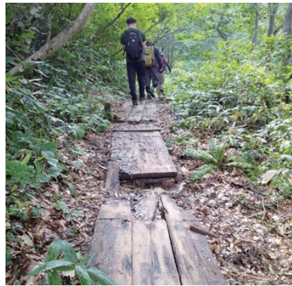
損傷した八海山登山道の木道
