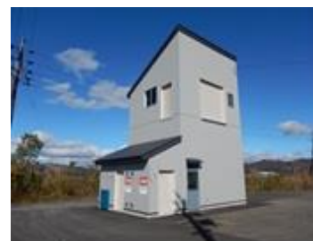
大和分署訓練塔
