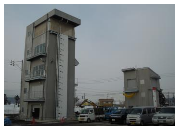
南魚沼市消防署訓練塔
