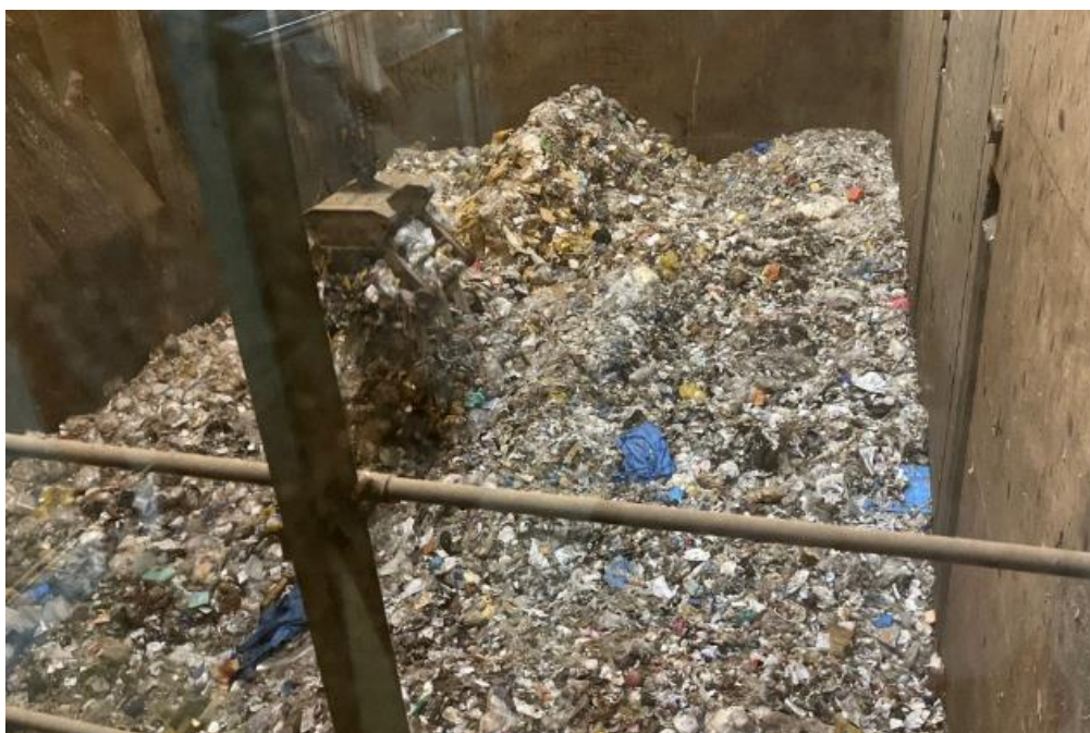
図 4-7 ごみピットの様子 (可燃ごみ処理施設)
