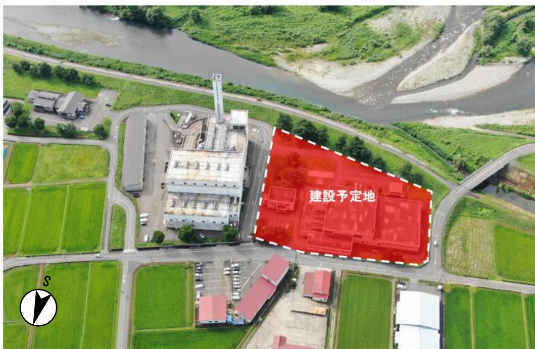
図 2-3 建設予定地の状況
