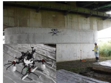
ドローンによる点検
