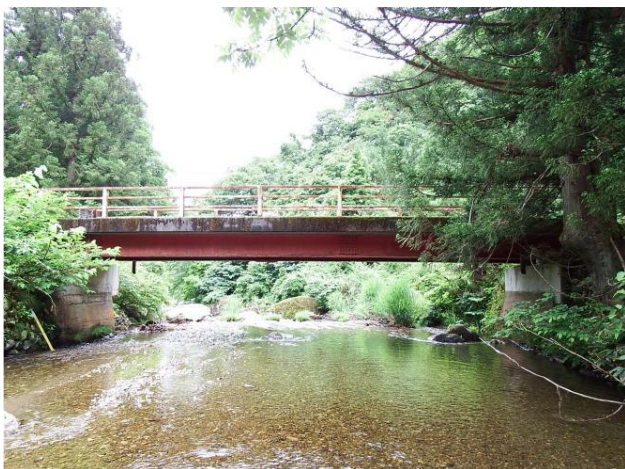
写真全景（鋼橋）
