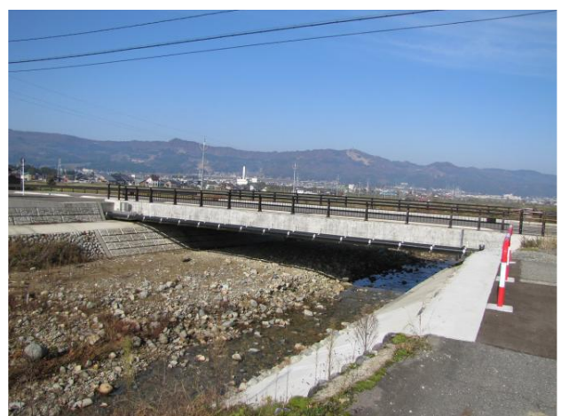
写真全景（コンクリート橋）
