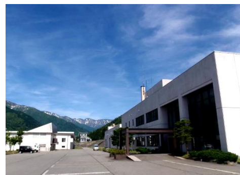
(畔地浄水場 管理棟)
