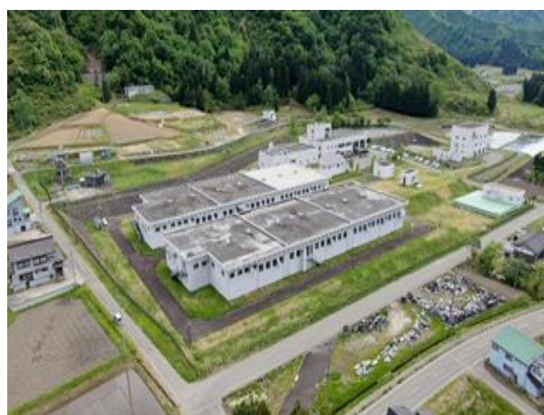
(畔地浄水場全景)
