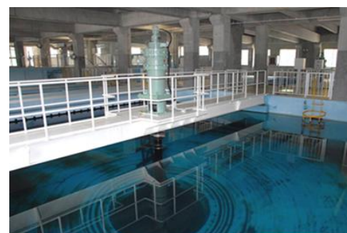
(畔地浄水場 沈殿池)
