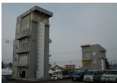
南魚沼市消防署訓練塔
