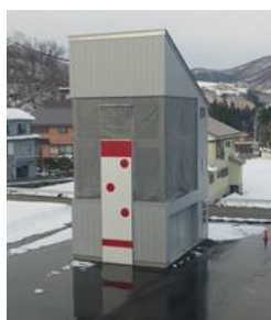
湯沢消防署訓練塔
