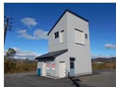
大和分署消防署訓練塔
