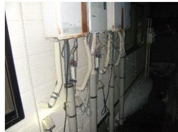
給水管がむき出しになっている
