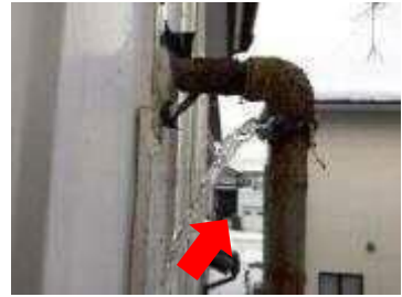
給水管がむき出しになっている
