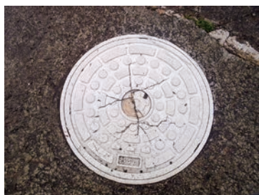
ひび割れて交換が必要な汚水マスのふた
