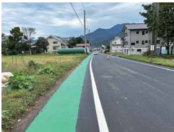
歩行者の安全を守るためのグリーンベルトの設置
