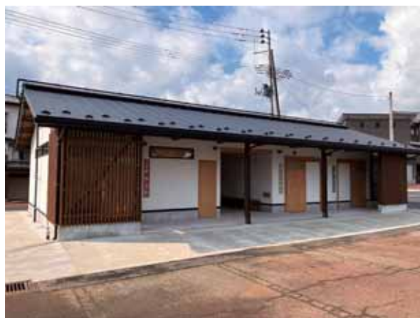
塩沢交流広場のトイレ改修
