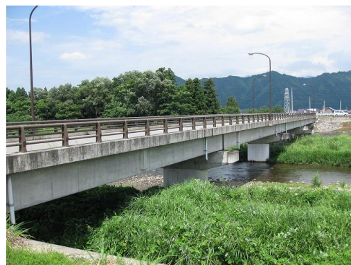
コンクリート橋
