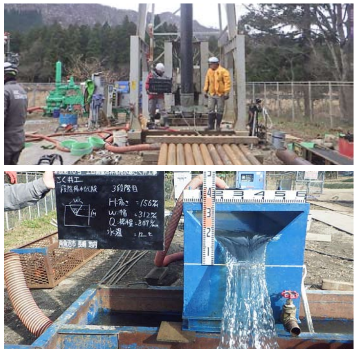
非常用水源の井戸さく井工事
